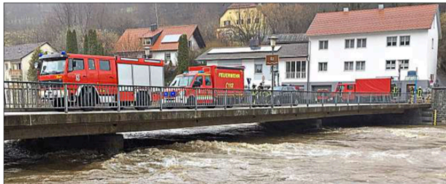
Nur wenige Zentimeter sollten am Samstagvormittag fehlen, und die Halser Brücke wäre zum unberechenbaren Staudamm für die unzähligen Äste und Baumstümpfe geworden, die angeschwemmt wurden und knapp noch den Weg unter der Überführung hindurch fanden. – Foto: Karl
