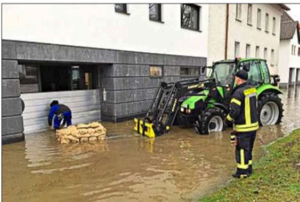
Das Gebäude im Pustetweg stand schon im Wasser, als die Sandsäcke kamen. Die Alu-Spundwand verhinderte Schlimmeres. – Foto: Karl
