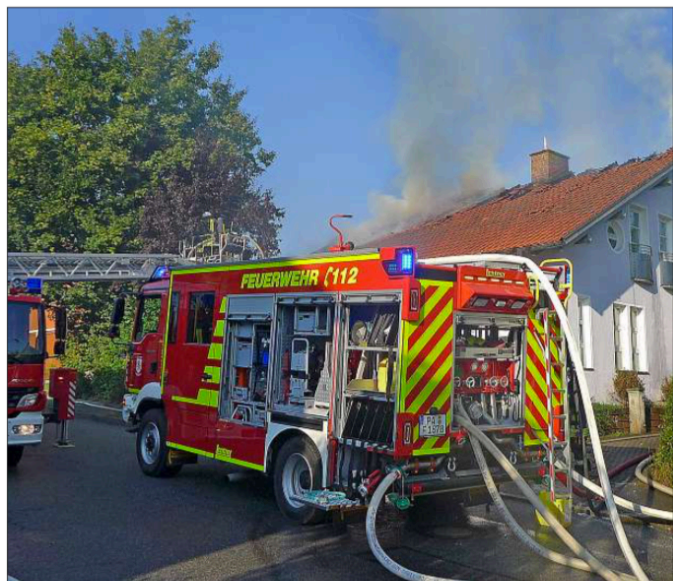
Um den Dachstuhlbrand zu bekämpfen mussten die Helfer der Feuerwehr die Ziegel abdecken. Die Löschwasserversorgung aus Hydranten funktionierte problemlos. – Fotos: Lampelsdorfer
