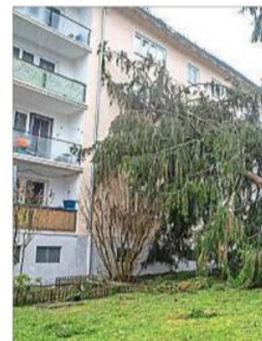
Ein Baum landete in der Kraftstraße in einem Mietshaus.
