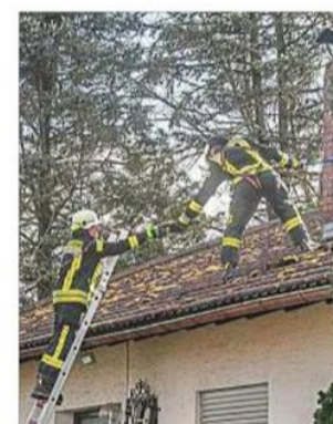
Dachdecken wurde im Bereich Rennweg/Bockhof nötig.
