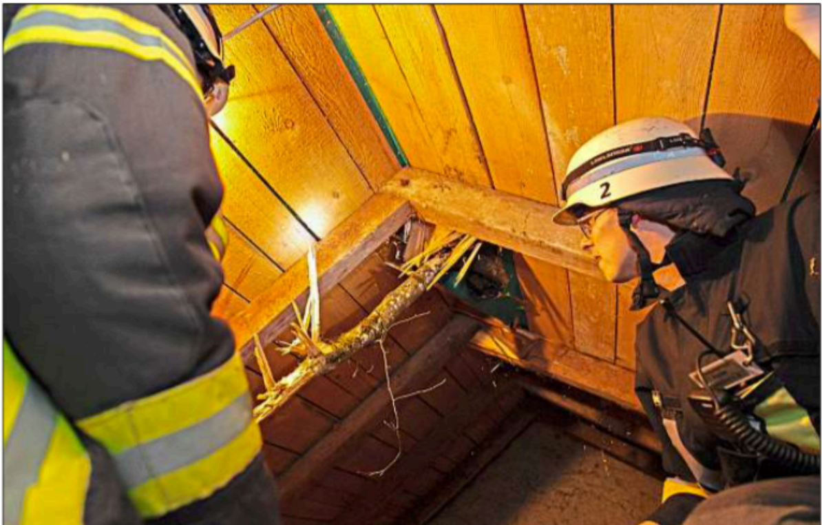
Durchs Dach gekracht ist ein Baum bei einem Haus in der Leonhard-Paminger-Straße am Sonntagabend. Feuerwehrleute des benachbarten Löschzugs Hauptwache kümmern sich darum. – Foto: Kornexl/FF Passau
